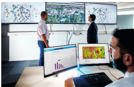
«L'hyperviseur». Ce centre de contrôle permet de gérer tous les fluides, du chauffage à la climatisation en passant par la lumière en fonction de l'occupation des salles, pour faire baisser la note de 20%.
