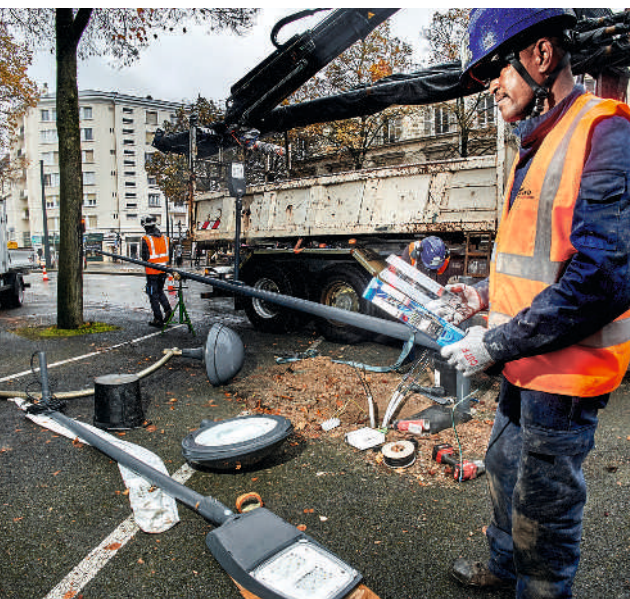
Rénovation de l'éclairage public. 30 000 lampadaires sont concernés. La ville espère 66% d'économies d'ici à 2025.
