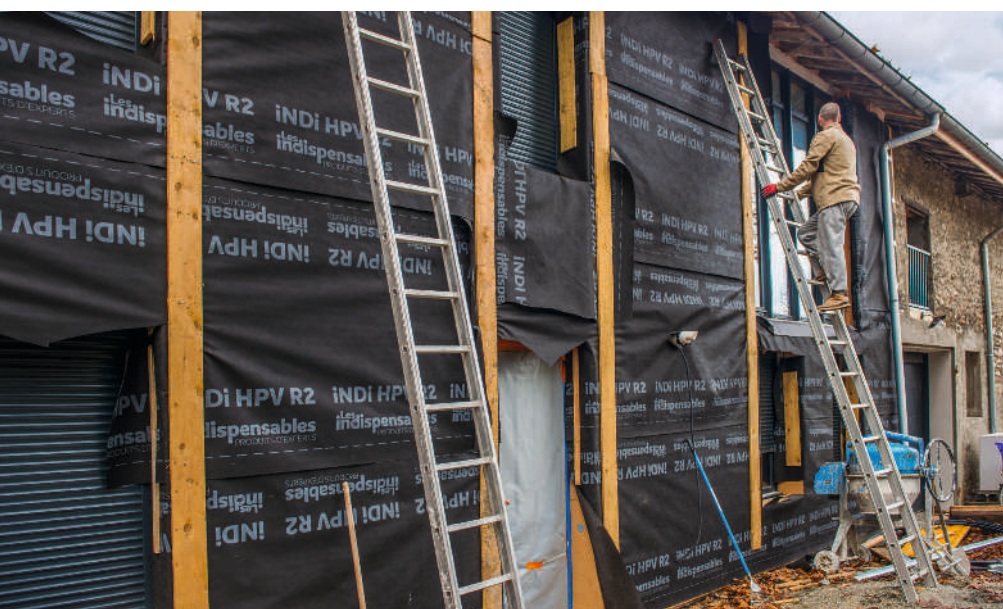
Chantier à Saint-Egrève (Isère). MaPrimeRénov' (10 000 euros maximum) varie selon les revenus du foyer, le nombre d'occupants du logement, sa localisation et le « gain écologique » des travaux.
